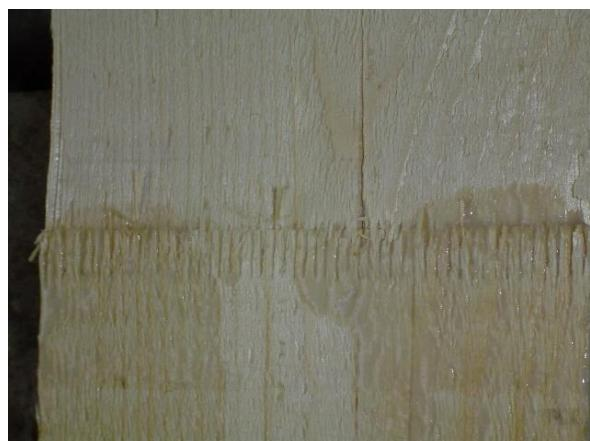
Slika 8 Izvedeni zupčasti nastavak
