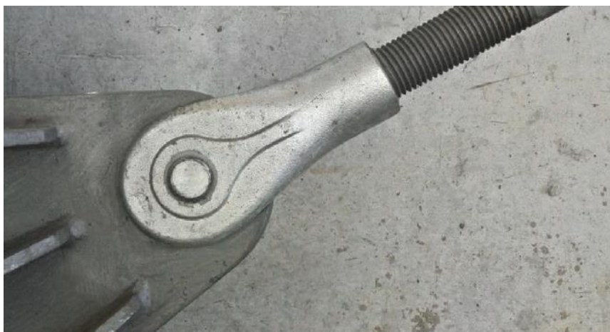
Slika 13 ZVB element u konstrukciji
