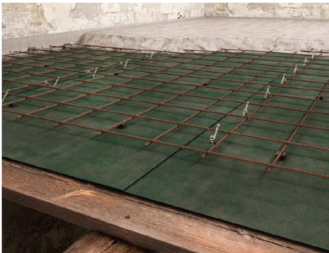
Slika 10 Prikaz primjene VB vijaka kod sanacija međukatnih konstrukcija
